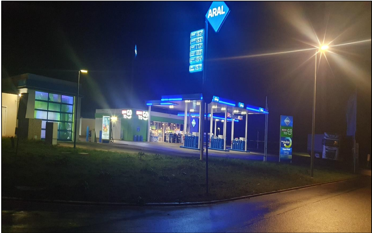
Abbildung 15: Nächtliche Beleuchtung am Rande des Bauabschnittes 1 „Zufahrt der Aral-Tankstelle“ in Richtung des FFH-Gebietes „Endseer Berg“. Foto: 04.12.2024, R. Bolz.
